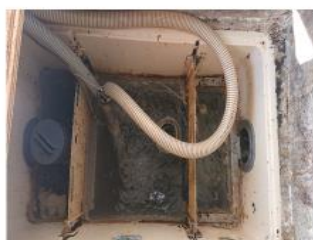
排水溝を清掃した当日
