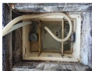
排水溝を清掃して3日後
